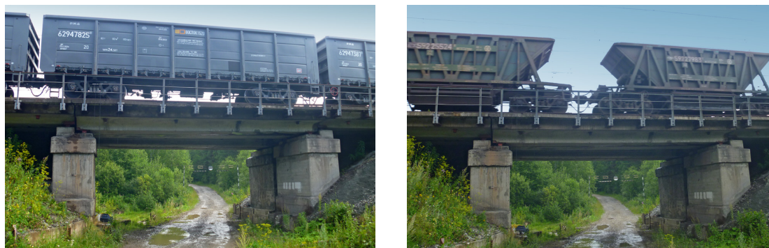
Рис. 5. Проведение испытаний пролетных строений и опор моста под испытательным поездом и обращающимися нагрузками
